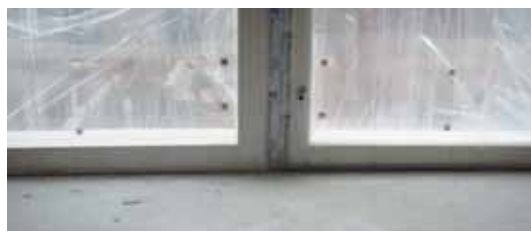
Lattialämmitys ei vie tilaa, jolloin esim. suurten ikkunapintojen toteutus on ongelmattonta.
