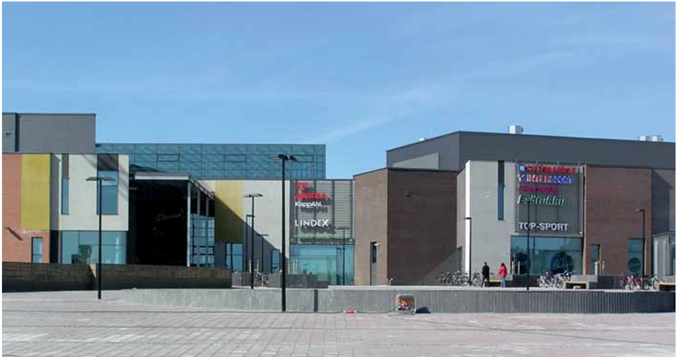
Lattialämmitys ja sulanapito yhdessä ovat energiatehokas ja huoltovapaa tapa lämmittää kauppakeskuksia.
