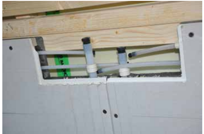
Syöttölinjat asennetaan aina vastakkain.
